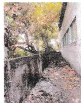
Se solicita el levantado de block ya que es un area que el salitre daña y oxida los metales y los pudre.
