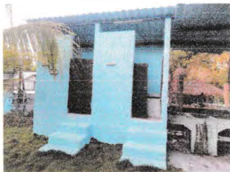
Implementación de losa en los servicios sanitarios
