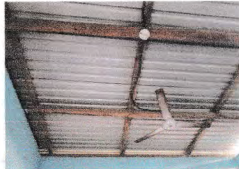
Sustitución de estructura de soporte madera por metal
