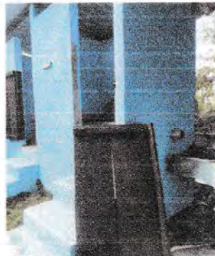
Sustitución de puertas de los servicios sanitarios de madera por puertas pvc
